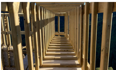
Fig. 4. Detalle del remate de los muros tras la intervención
